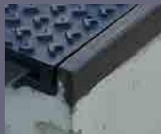
**Longerons fonte scellés dans le béton**
